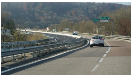
Première phase de travaux terminée à Ligny-en-Barrois
